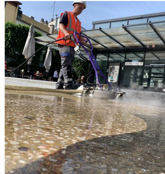
La haute pression (500 bars) combinée à une eau à 90°C agissent et permettent de nettoyer et d'éliminer efficacement les résidus accumulés au fil des saisons (dépôts, traces noires, mousses, mauvaises herbes...) sur des revêtements tels que :
